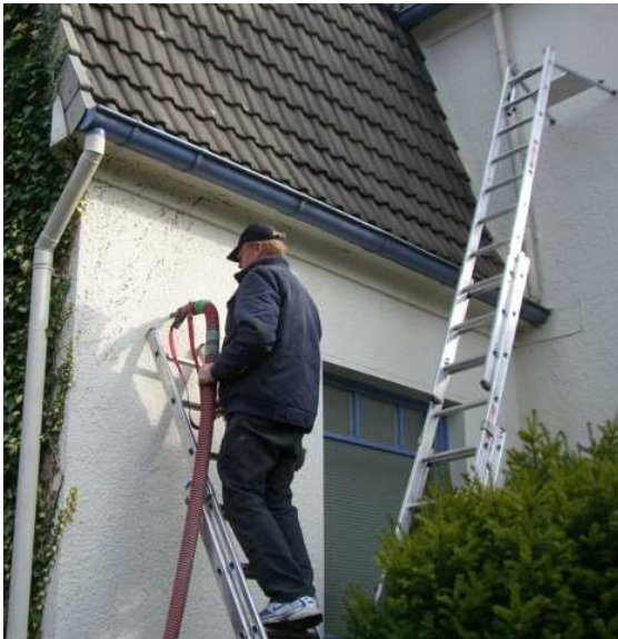
Dämmung der Außenwände
