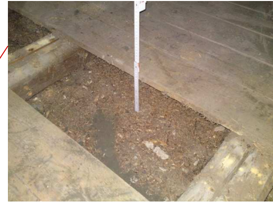
Dämmung der obersten Geschossdecke
