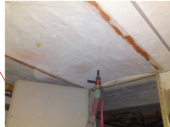
Dämmung der Kellerdecke
