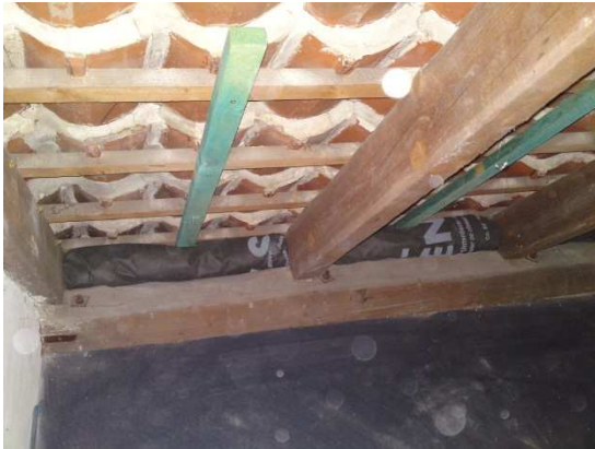
Dämmung der Dachschrägen
