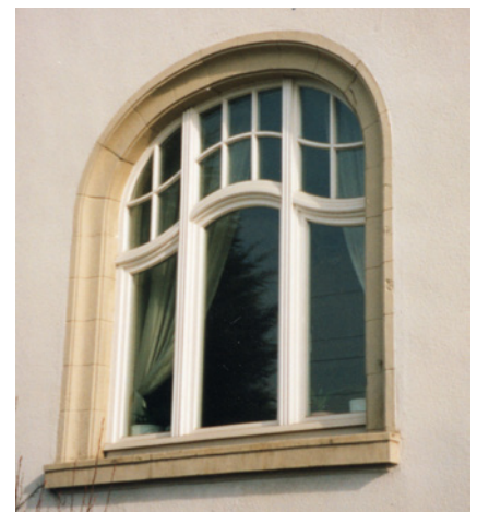
Bild rechts: Gelungene Fenstererneuerung in einem historischen Gebäude
