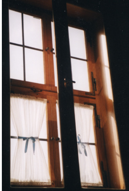
Kastenfenster im Denkmalschutz: Außen Einfachverglasung mit Sprossen, innen durchgehende Wärmeschutzverglasung.
