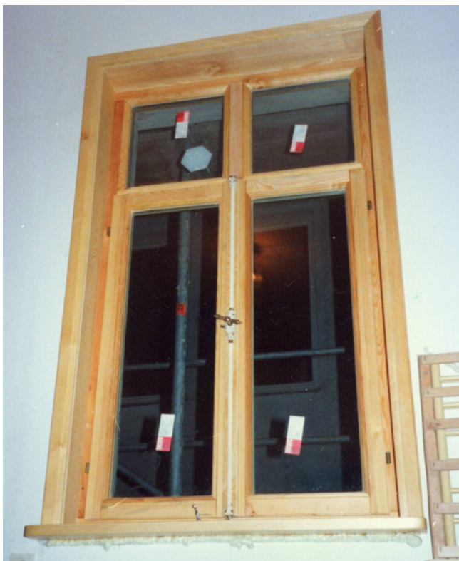
Neues Fenster mit originalgetreuem Holzrahmen und Wärmeschutz-Isolierverglasung (Die Beschläge wurden wieder verwendet)
