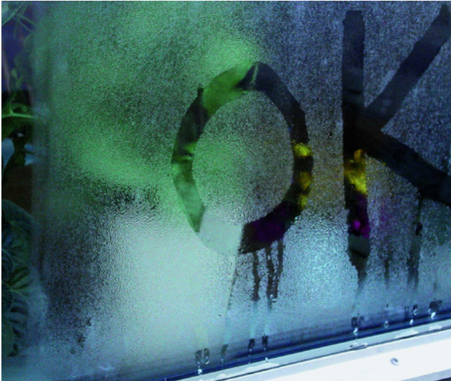
Außenkondensat am frühen Morgen auf einer Wärmeschutzverglasung ist ein Zeichen dafür, dass der Wärmetransport von innen nach außen sehr gering ist.
