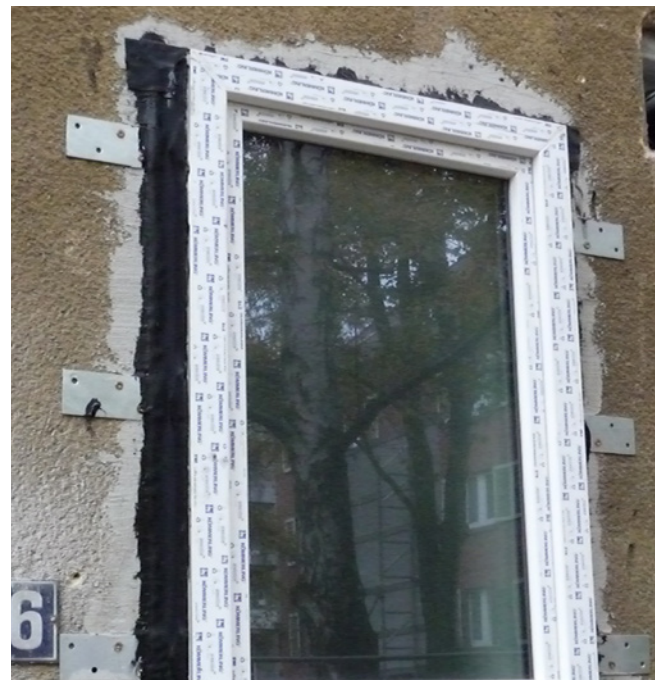
Montage eines Fensters vor dem Mauerwerk im Rahmen einer Modellsanierung, wobei die Abdichtung mit Glattstrich und Butylkautschukband erfolgt.
