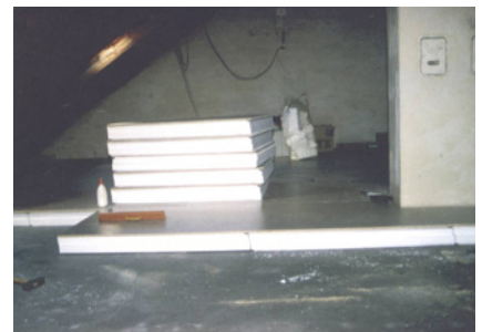
Auf dem Trockenboden dieses Mehrfamilienhauses werden begehbare Dämmplatten ausgelegt.
