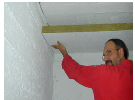
Dämmung einer Kellerdecke mit 6 bis 8 cm dicken Dämmplatten von unten beseitigt die „Fußkälte“ in der Erdgeschosswohnung.
