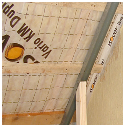
Luftdichtung unter den Sparren dicht einbauen
