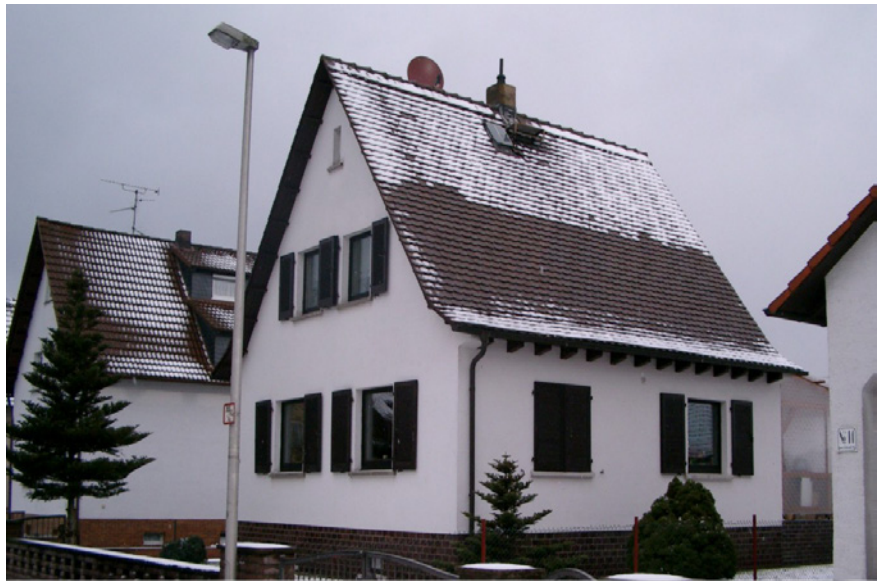
Die Wärme, die den Schnee auf diesem Dach geschmolzen hat, stammt aus der Heizanlage und hat den Hausbesitzer viel Geld gekostet.
