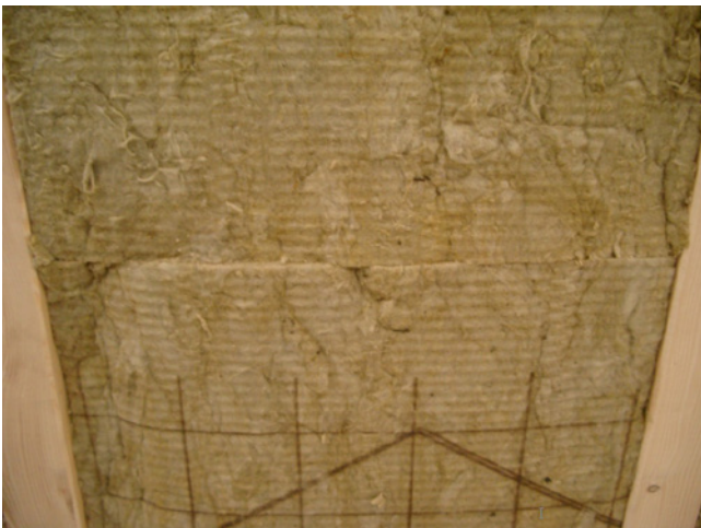
Dämmstoffe der Wärmeleitfähigkeitsstufe 035 bieten gute Dämmwirkung bei geringer Aufbauhöhe
