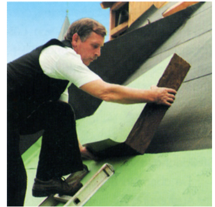
Dämmplatten aus Mineralfasern mit aufkaschierter Unterspannbahn
