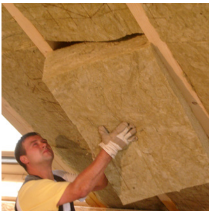
Dämmstoff sparrenhoch einbauen = 12 - 14 cm
