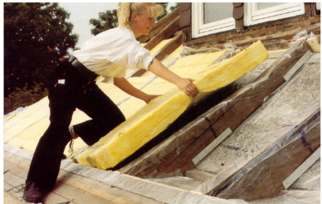
Die feuchteadaptive Dampfbremse wird zwischen die Sparrenfelder verlegt.
