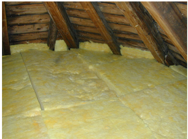
Mineralfaserplatten von 20cm Stärke dämmen diesen Spitzboden. Die Platten sind auch in den Sparrenzwischenraum hineingeschoben. Damit schließt die Dämmung an die Zwischensparrendämmung lückenlos an.
