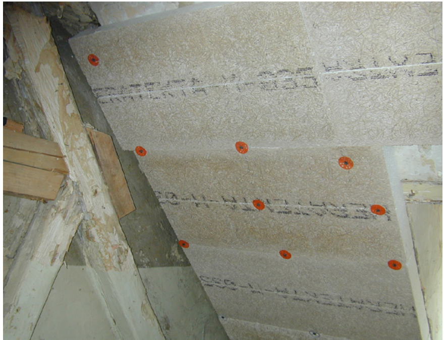
Die Hartschaumverbundplatten wurden unter den alten Innenputz der Dachschräge befestigt. Sie werden verputzt. Der Innenputz ist die notwendige luftdichtende Ebene, die Hartschaumplatten bilden die diffusionshemmende Schicht.
