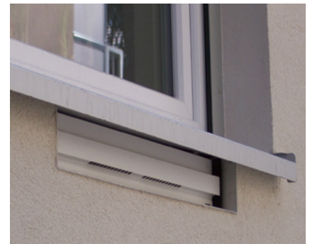
Zuluftelement einer Abluftanlage zum Einbau unterhalb der Fensterbank hinter dem Heizkörper
