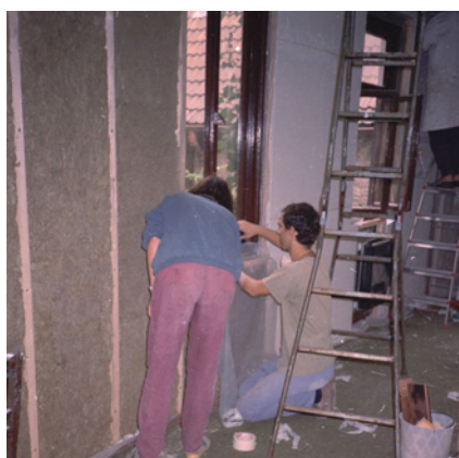
Innendämmung aus Mineralfaserplatten mit Dampfbremse; hier die Herstellung des Anschlusses am Fensterrahmen
