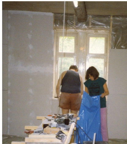
Montage einer Innendämmung in einem kleinen Bauernhaus Baujahr 1913 mit Mineralfaserdämmung, Dampfbremse und Gipskartonplatten.
